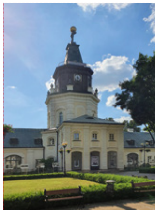
↑ КОЛИШНЯ РАТУША. ЗАРАЗ ТУТ МІСТИТЬСЯ РЕГІОНАЛЬНИЙ МУЗЕЙ ↑ fot. arch. MROT
