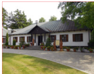
↑ ↑ «РЕЙМОНТІВКА» АБО «ДІМ ВДОВИ РЕЙМОНТА» fot. arch. Domu Pracy Twórczej
