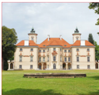
↑ ↓ PALAC W OTWOCKU WIELKIM fot. arch. MR.OT
