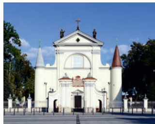
BAZYLIKA PW. WNIEBOWZIĘCIA NMP ↑ ↑ fot. GHG
