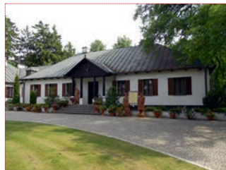
↑ ↑ REYMONTÓWKA fot. arch. Domu Pracy Twórczej
