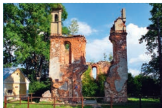
→ RUINY ZAMKOWEGO KOŚCIOŁA W MIELNIKU → fot. Adobe Stock
