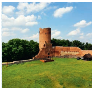
→ ZAMEK W CZERSKU → fot. arch. MRÓT
