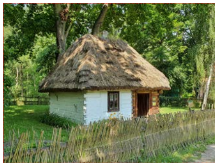
↑ ↑ COTTAGE „BIEDNIAČA” FROM BARTODZIEJE photo: arch. MRQT
