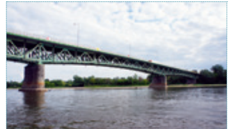
→ NADWIŚLAŃSKIE URZECZE ROAD BRIDGE → photo: Tadeusz Rudzki, CC BY-SA 4.0, WC
